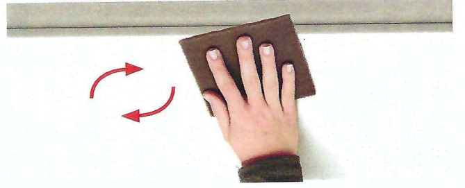
7. Carteggiare il materiale in eccesso con tampone (H) e carta Grana 180 (A) fino a pareggiare la superficie, poi procedere con tampone e carta Grana 240 (B) per rifinire la superficie
